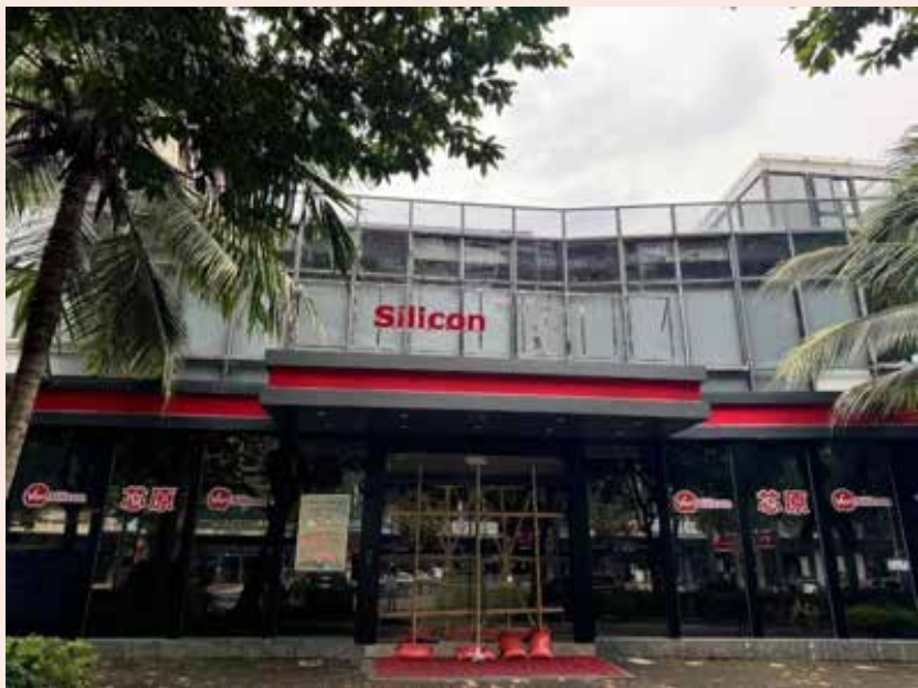
▲ 拆除公司正门广告牌
